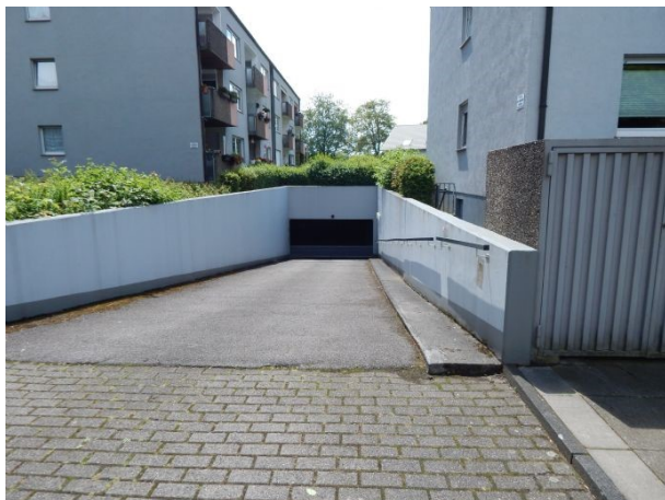
Einfahrt zur Tiefgarage
