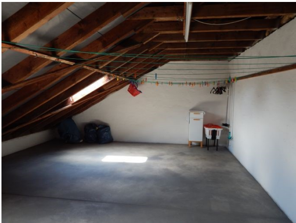
Trockenraum im Dachgeschoss
